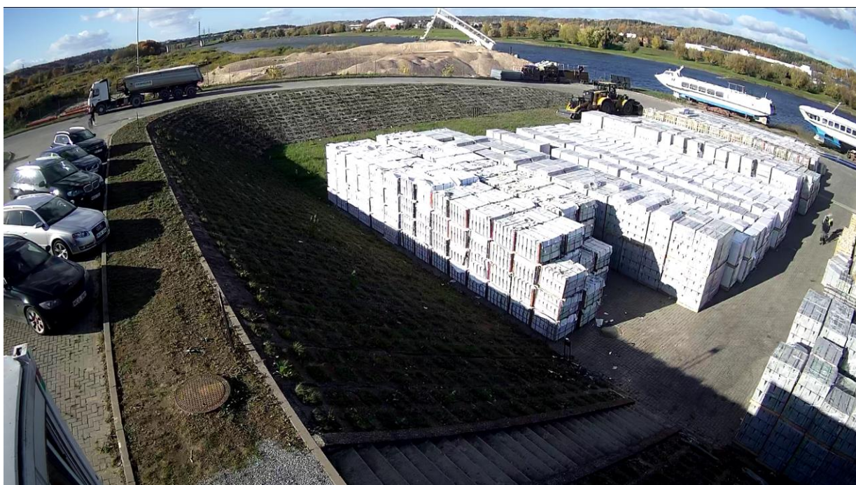
27 pav. Esamos prieplaukos vaizdas nuo PŪV teritorijoje esančio privažiuojamo kelio
