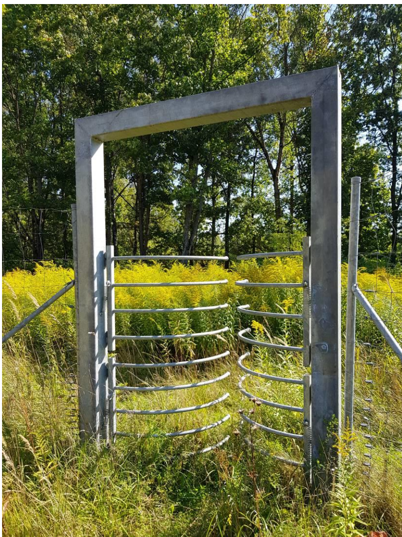
59 pav. Vienkrypčiai varteliai įrengti aptvertame geležinkelio ruože Jiesios kraštovaizdžio draustinyje
