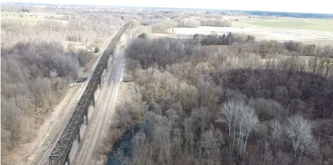
39 pav. Esamas geležinkelio tiltas per Jiesią. Greta jo planuojamas naujas geležinkelio tiltas ir viadukas (viršuj – esama situacija, apačioje – galimas kraštovaizdžio pokytis po PŪV įgyvendinimo) (40 pav. pažymėta 4 Nr.)
