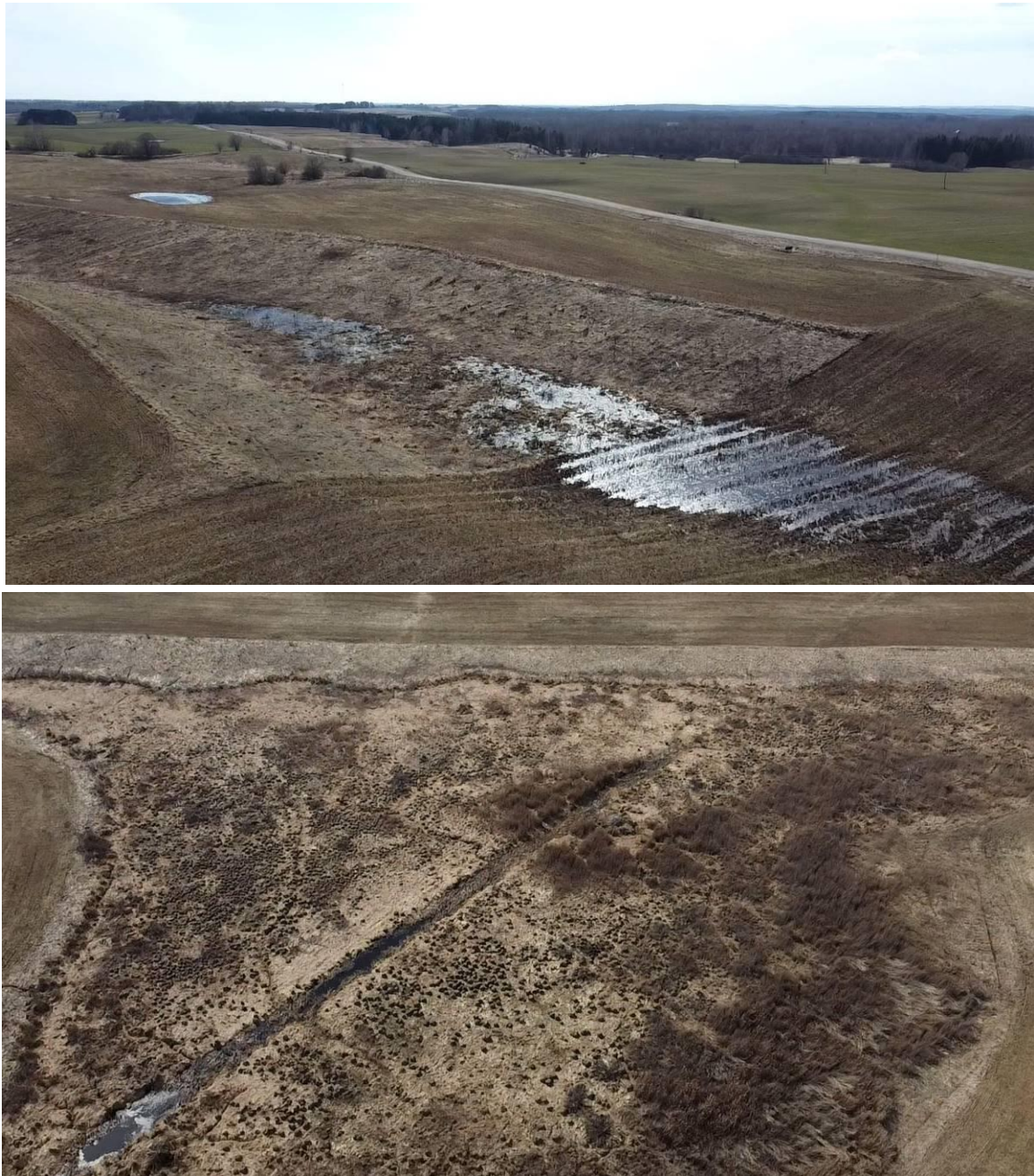
13 pav. Melioracijos įrenginių būklė nagrinėjamame sklype iš paukščio skrydžio
