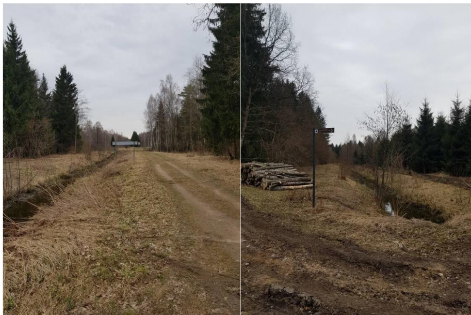
6 pav. Analizuojamoje teritorijoje esančio melioracijos griovio būklė pavasario metu
