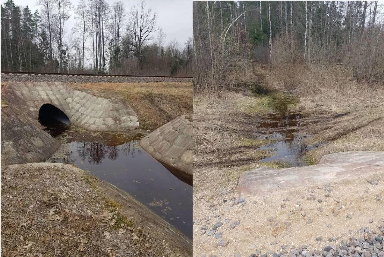
5 pav. Kairėje - melioracijos griovys, pralaida po esama geležinkelio vėže (nuo planuojamos Kauno depo teritorijos lik vakarų pusės). Dešinėje - melioracijos griovys (nuo esamos geležinkelio vėžės link vakarų pusės)
