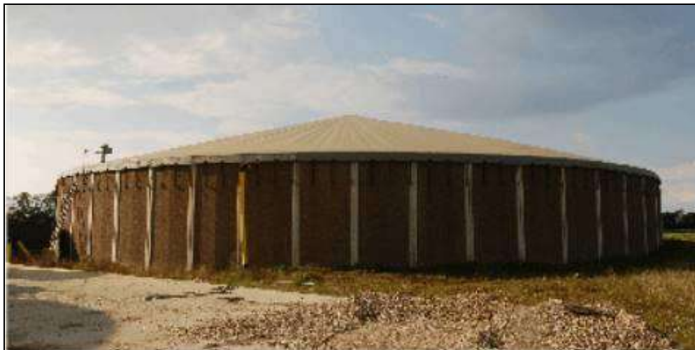
15 pav. Pavyzdys skysto mėšlo rezervuaro uždengto pakabinama plastiko danga (tentu).
