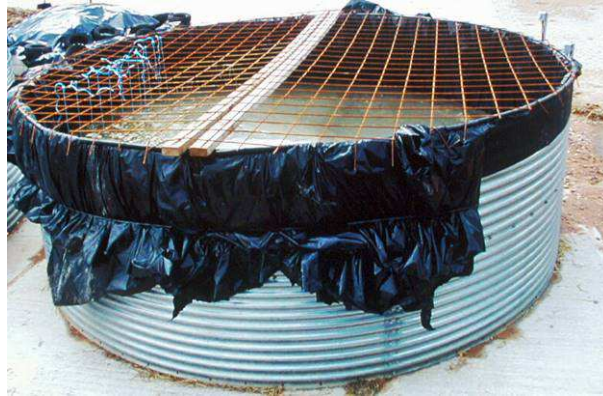
9 pav. Ruošiama kietos dangos paviršiui
