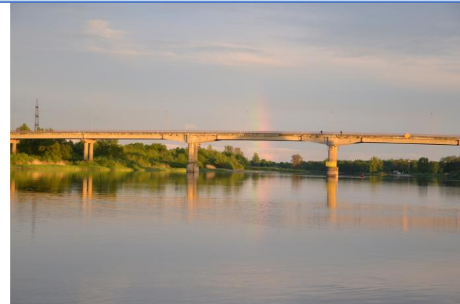
42 pav. Už 420 m nuo estakados esantis tiltas per Atmatą
